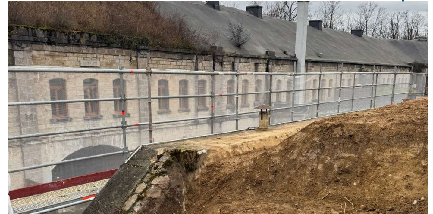
Étanchéité du toit
